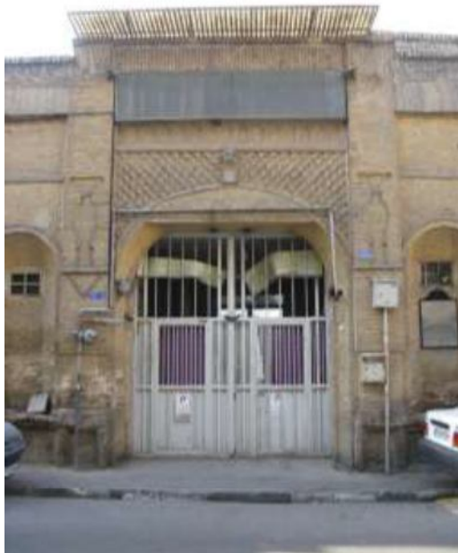
سردر آجری مریم‌بخانه شیخ هادی در کوچه شهید حسین سنخ‌نور (فعلی) یا وزیری (سابق) در خیابان شیخ هادی تهران. از عمارت قجری مریم‌بخانه تنها همین سردر آجری که بنای بیرونی و ورودی بیمارستان بوده به‌جا مانده است/عکس: علی شهیدی
